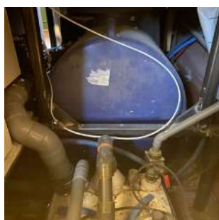
Installazione del Sanicubic 2 Pro e del Sanigrease S 680
