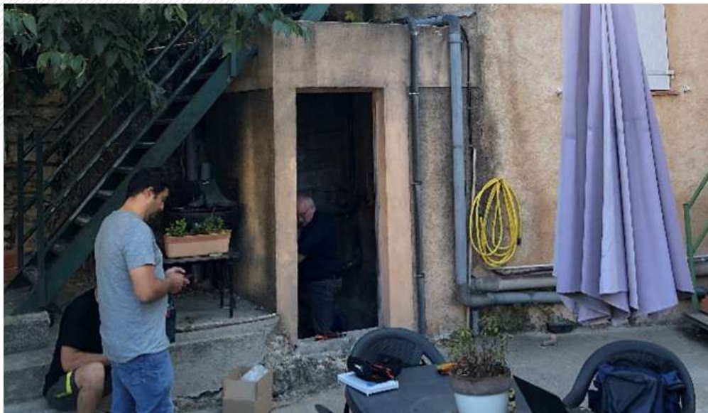
Posa della stazione di sollevamento
