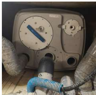
Sanicubic 1 VX installato nel garage
