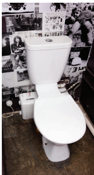
Sanibest Pro installato nel seminterrato
