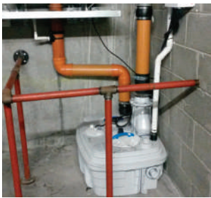
Sanicubic 2 VX installato in un locale tecnico
