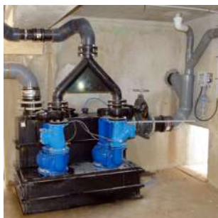
Sanicubic 2 SC installato nella cantina
