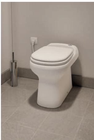
Sanicompact Elite installato per creare un bagno per i clienti.
